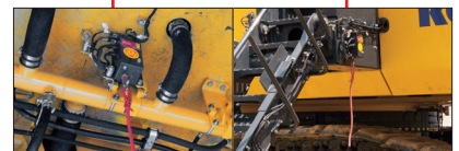
Кнопки аварийной остановки двигателя
